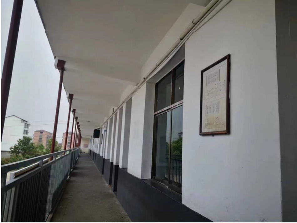
教学楼翻新之后的照片
